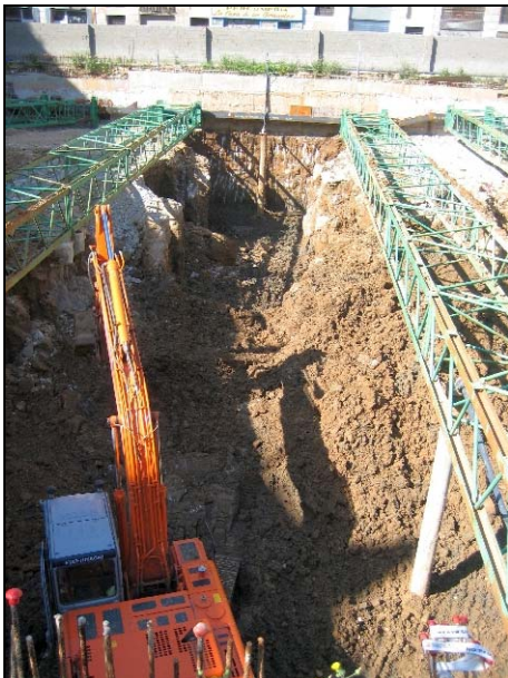
FOTO 63. Procés de rebaix de la darrera fase.
