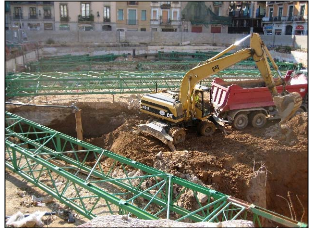
FOTO 62. Inici dels treballs de rebaix de la darrera fase.
