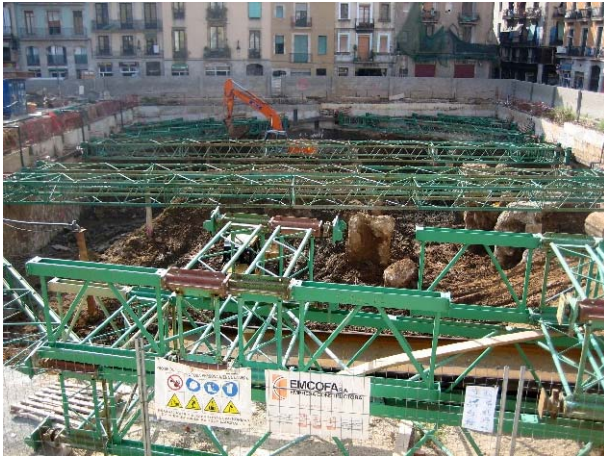
FOTO 61. Vista general del solar a l'inici del rebaix de la darrera fase.
