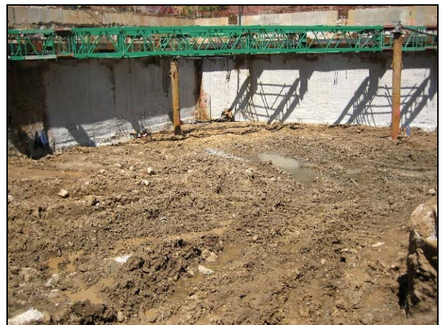
FOTO 64. Vista de la cota final del rebaix de la darrera fase.
