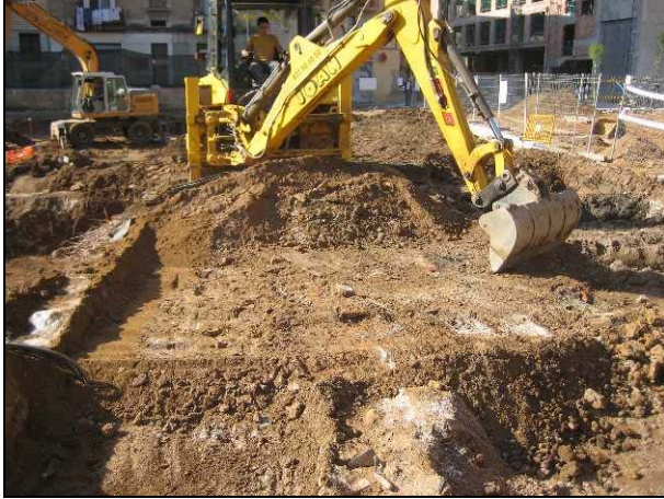
FOTO 5. Treballs amb màquina al sector A.
