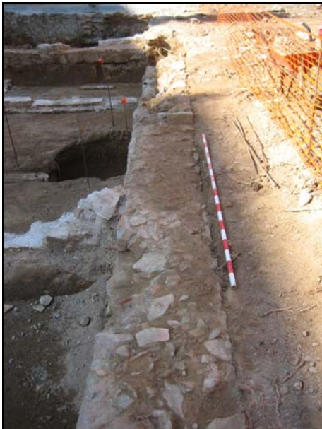
FOTO 15. Mur UE 88 i la seva banqueteta UE 531.
